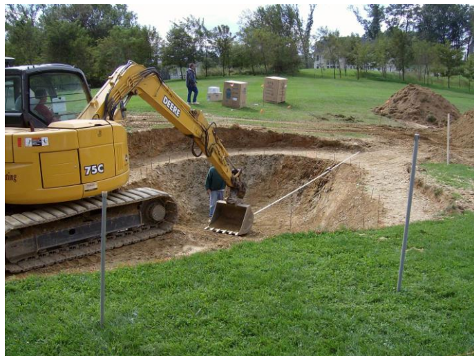
Figura 3.3.1.3. Deșeuri de la excavări
